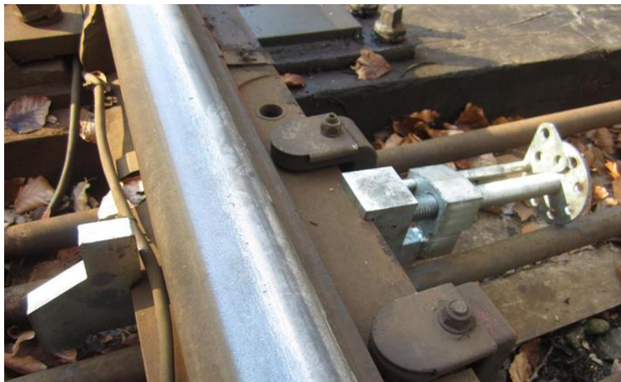
Montering af låsebolt type 3 "Banedanmark 2002" på tilliggende tunge
