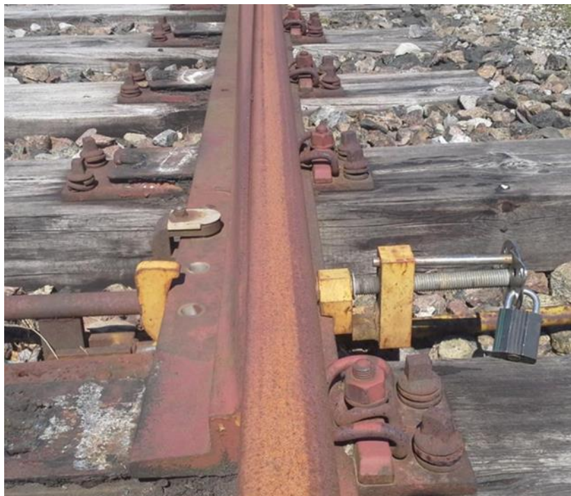
Montering af låsebolt type 1. "1975" på tilliggende tunge
