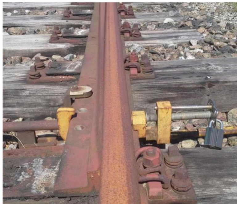
Montering af låsebolt type 1. "1975" på tilliggende tunge
