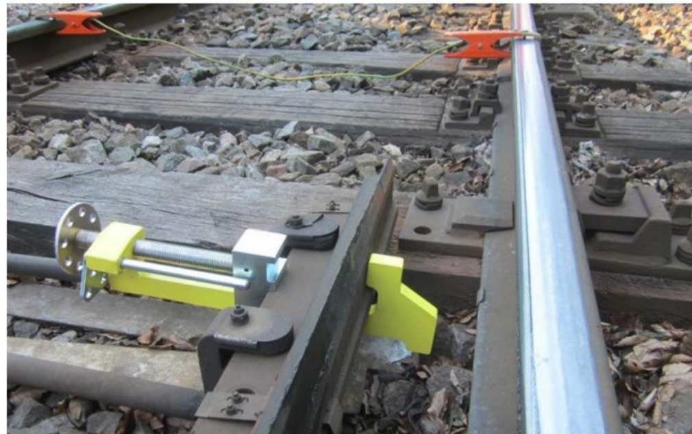
Montering af låsebolt type 4 "Banedanmark 2017" på fra liggende tunge.
