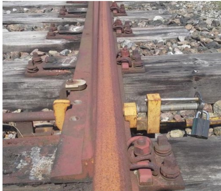
Montering af låsebolt type 1. "1975" på tilliggende tunge
