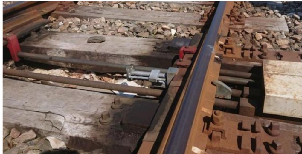
Montering af låsebolt type 2 "Banedanmark 1981" på tilliggende tunge
